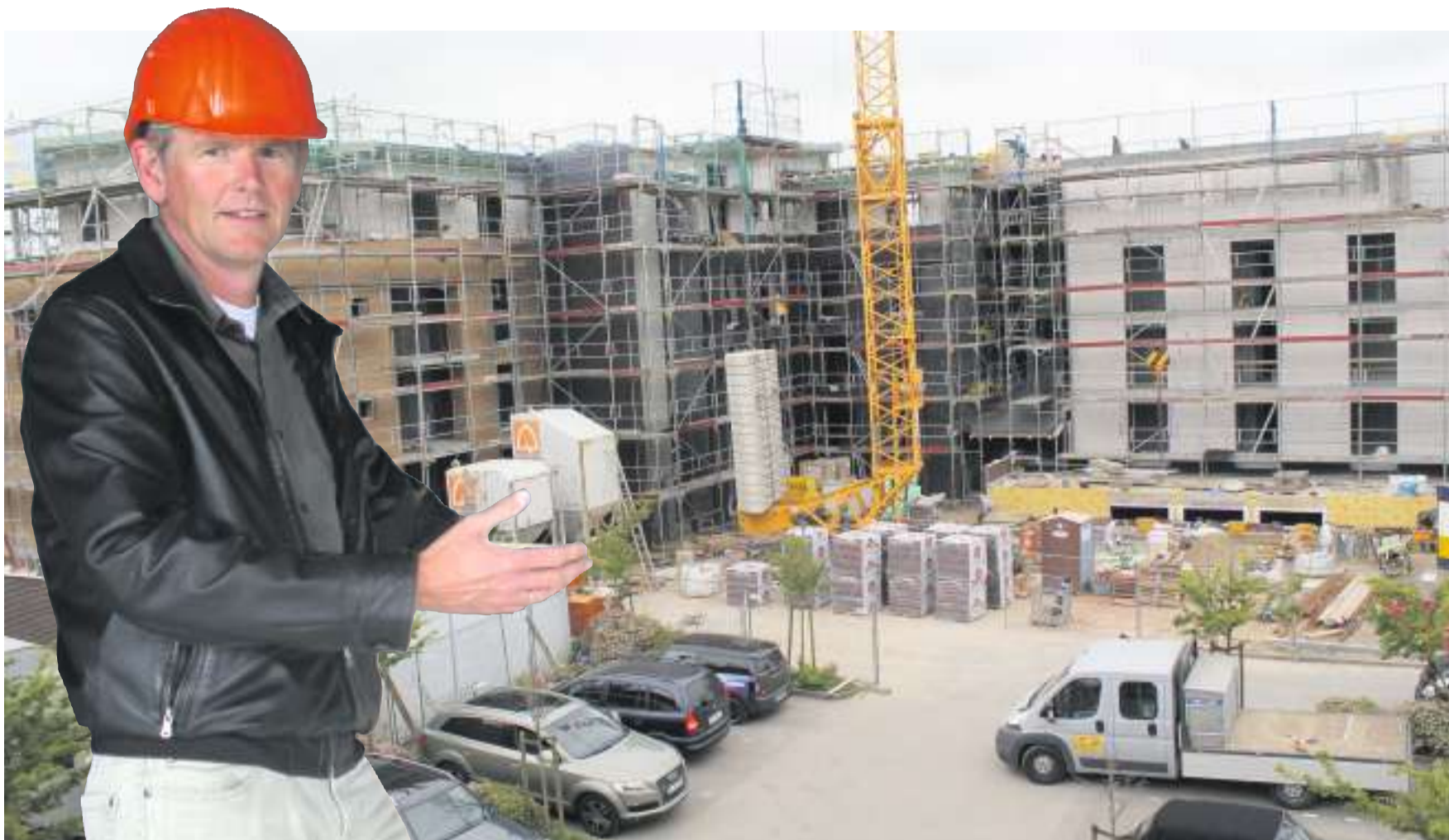
Bauherr Torsten Peters (l.) lädt zusammen mit Architekt Bernd Biastoch am 28. Juni zum Rundgang durch die Baustelle »Stadtquartier am Husumer Hafenspeicher« ein. Bis Frühjahr 2015 werden hier 31 neue Wohnungen entstanden sein.
